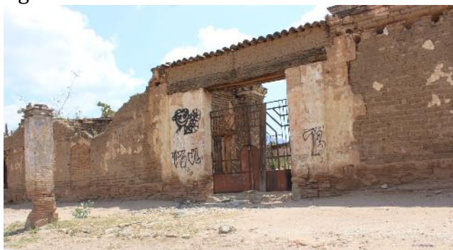
Imagen 10. Construcción de una vivienda con adobe
