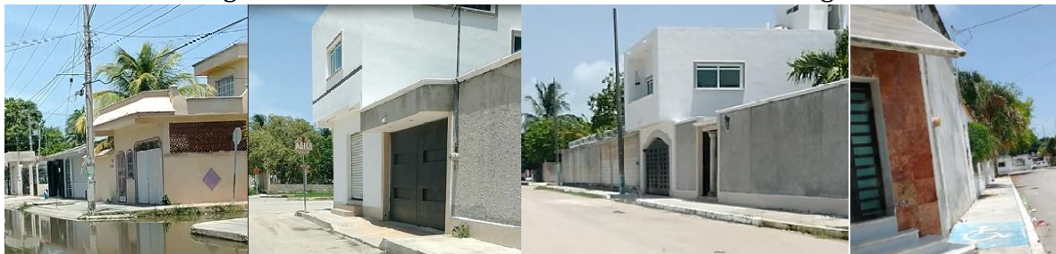
Imagen 3. Vivienda informal en la Colonia Nuevo Progreso
